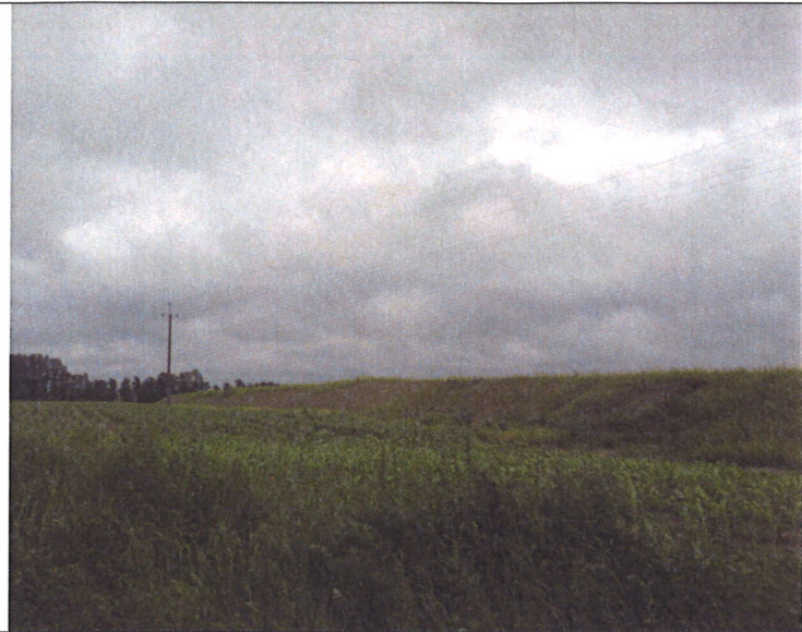
Okolice zbiornika z drogi 2KD-L
