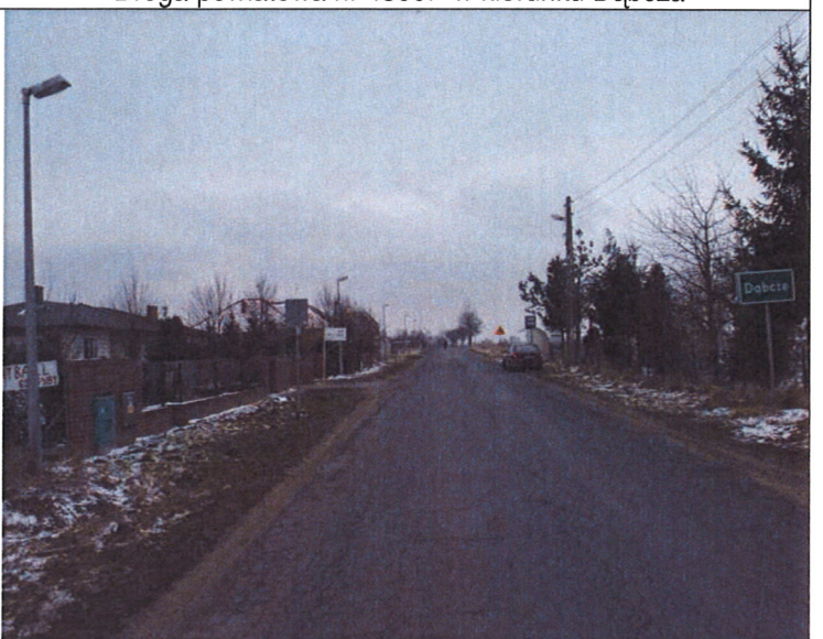
Droga powiatowa nr 4800P na granicy Dąbcza i Rydzyny
