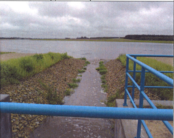
Zbiornik Rydzyna z drogi 2KD-L
