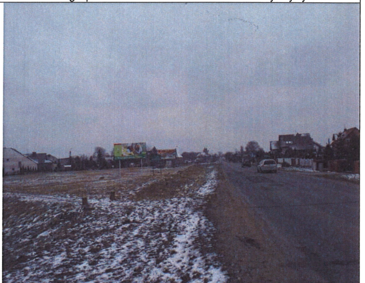
Droga powiatowa nr 4800P w kierunku Dąbcza
