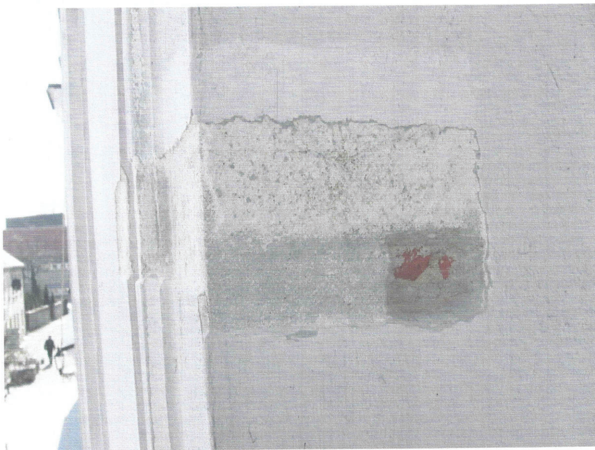
9. Odkrywka nr 8. Glif okienny na piętrze.
