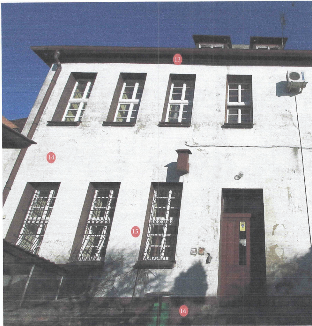
1. Widok elewacji tylnej z zaznaczonymi miejscami odkrywek
