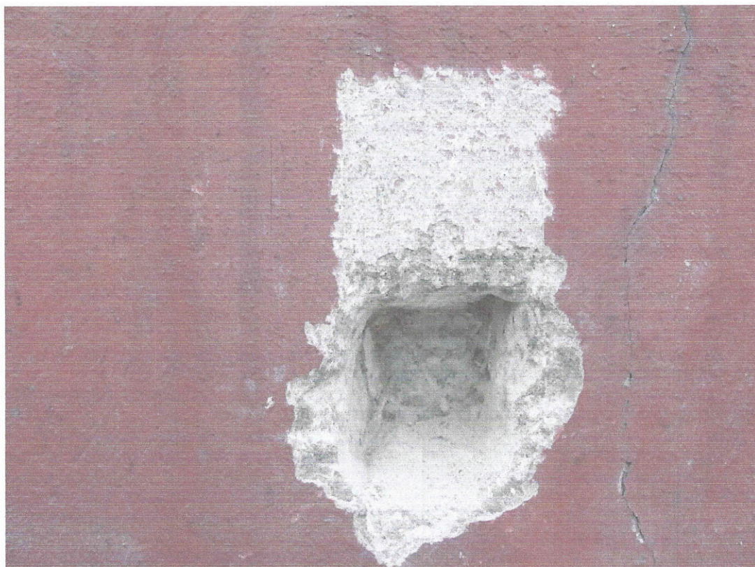
14.Odkrywka nr 12. Cokół.
