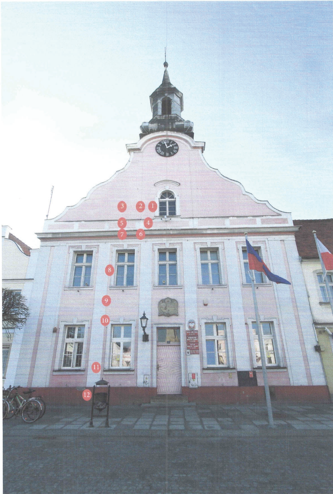
1. Widok fasady frontowej z zaznaczonymi miejscami wykonanych odkrywek.
