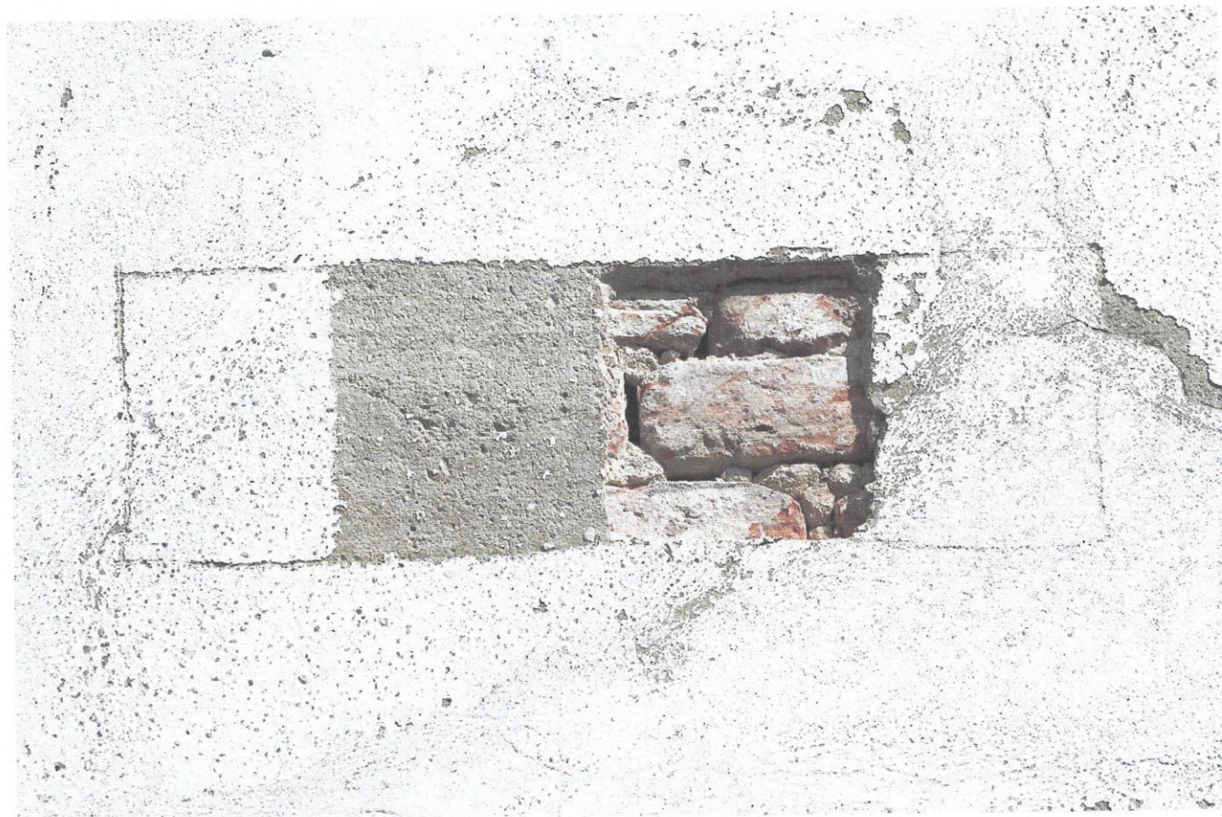
3. Odkrywka 14. Ściana na wysokości piętra.
