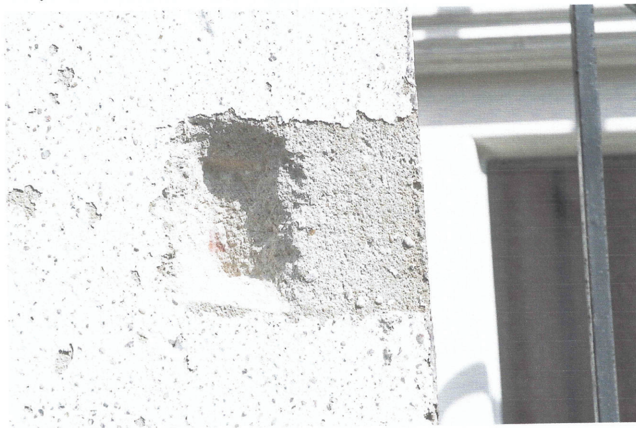
4. Odkrywka 15. Ściana przy otworze okiennym na parterze.
